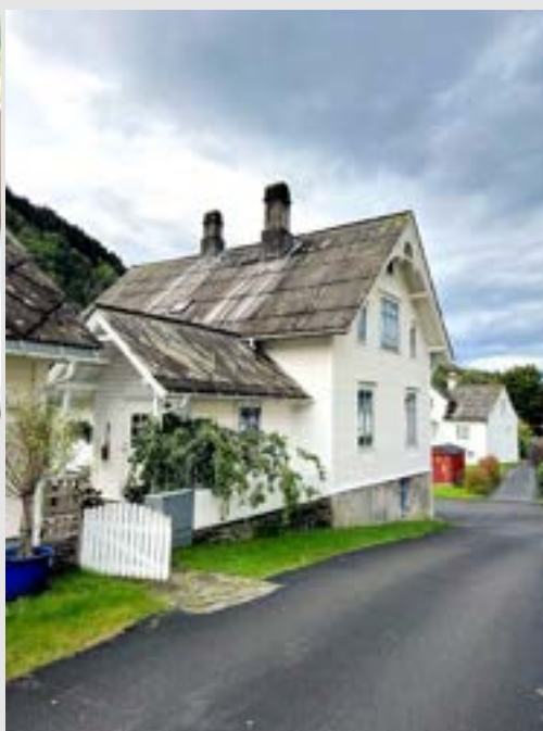
Jondal er ennå en vakker bygd. Legg merke til takhellene. Hardangerskifer? (Red. komm: Sikkert. Sollesnes skiferbrudd ligger like innom Jondal).
