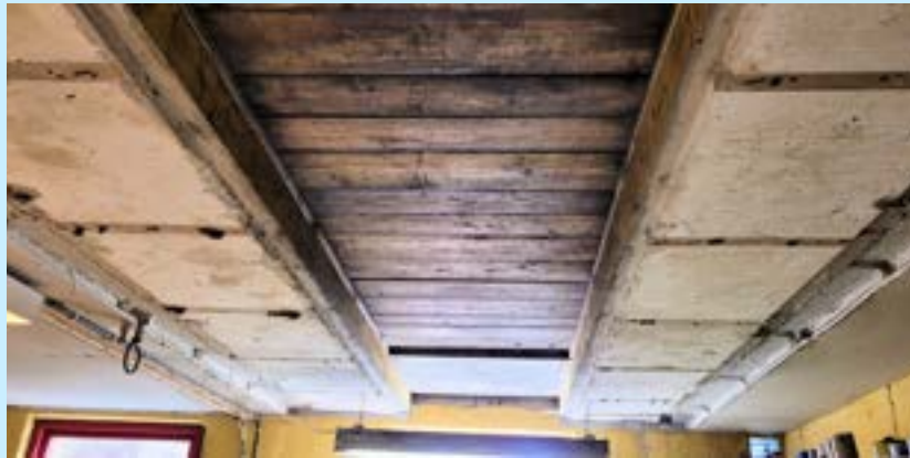
Fra underetasjen. Vi ser der det åpnes og senkedelen.
